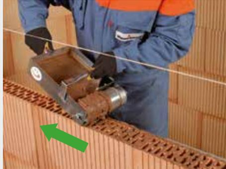
**2** Après avoir dépeussieré et humidifié les faces des briques à encoller, appliquer le mortier pour joints minces à l'aide d'un rouleau équipé d'une pige de réduction.
